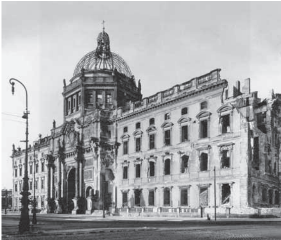
Abbildung 6: Berliner Schloss, Westfassade nach Kriegszerstörung etwa 1949, Quelle: Förderverein Berliner Schloss e.V.
